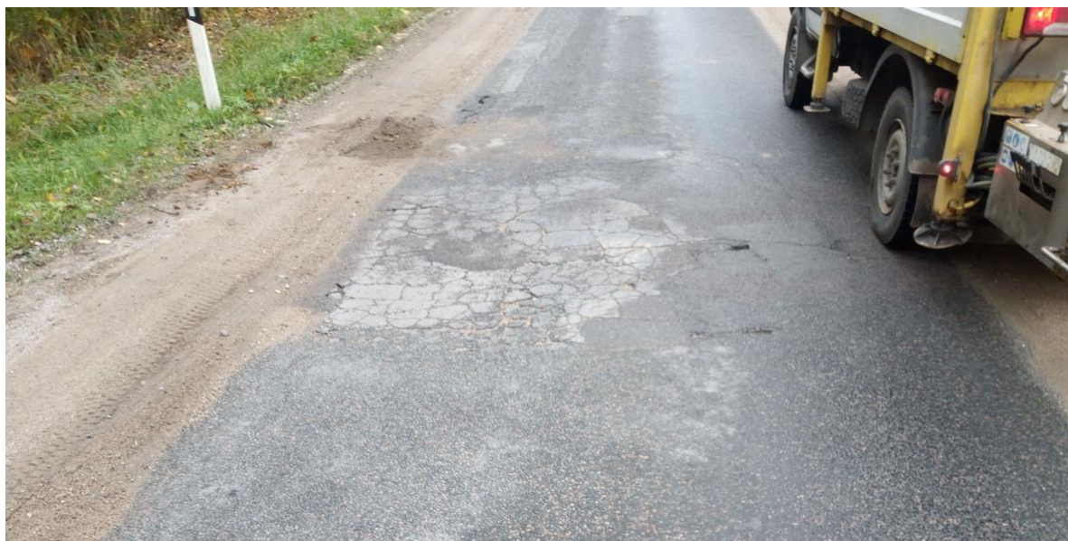
3 pav. Dangos konstrukcijos deformacija ties pralaida, Pk 125+65
